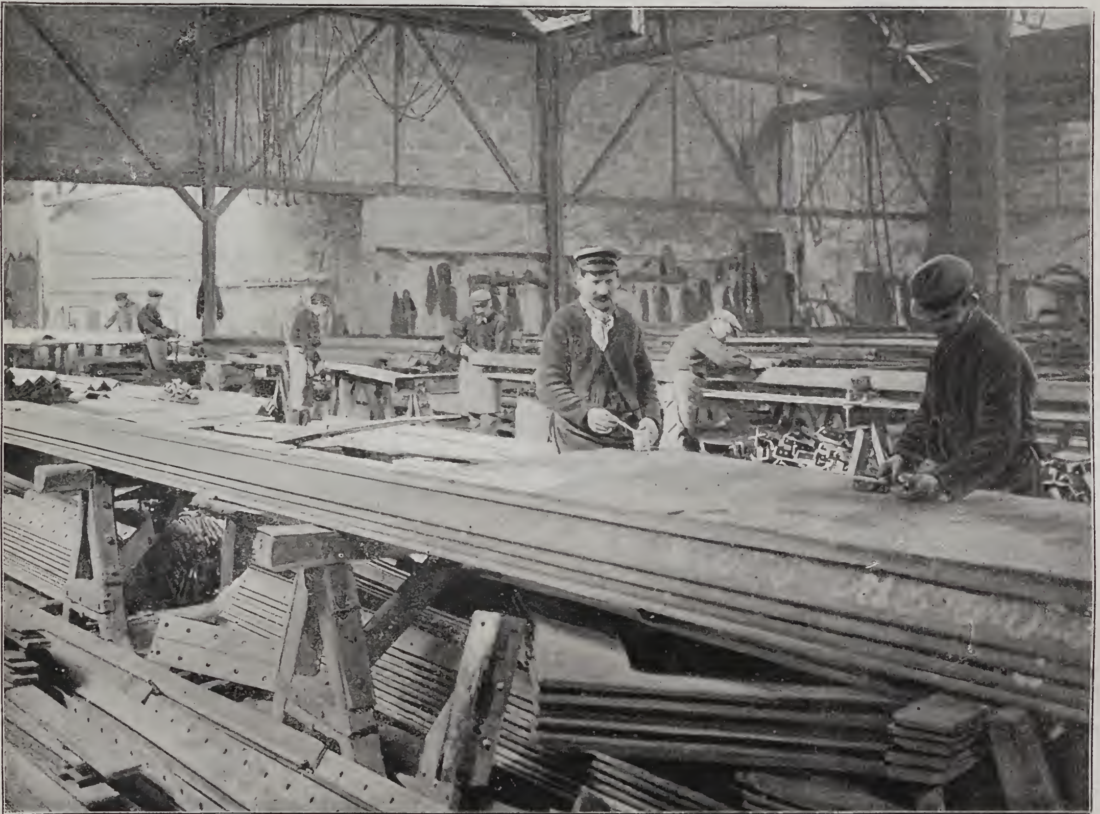
LES CHARPENTES EN FER. — Opération du traçage des fers.
